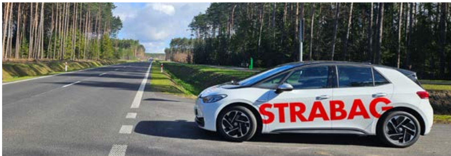
Fot. Elektryczny VW ID.3 PRO wykorzystywany na budowie Południowej Obwodnicy Zielonej Góry
