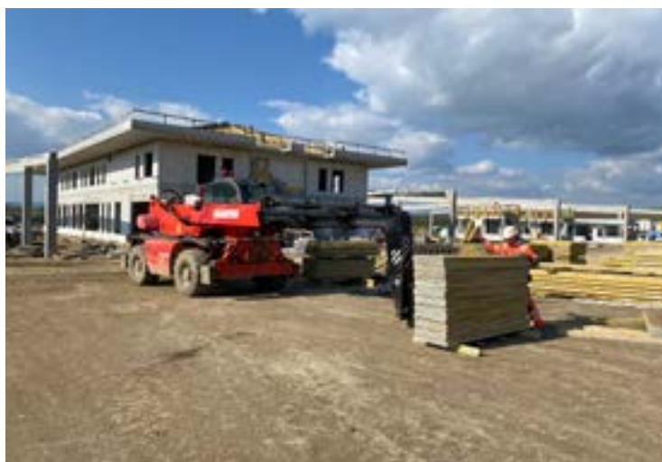
Fot. Prace na budowie, kwiecień 2023 r.
