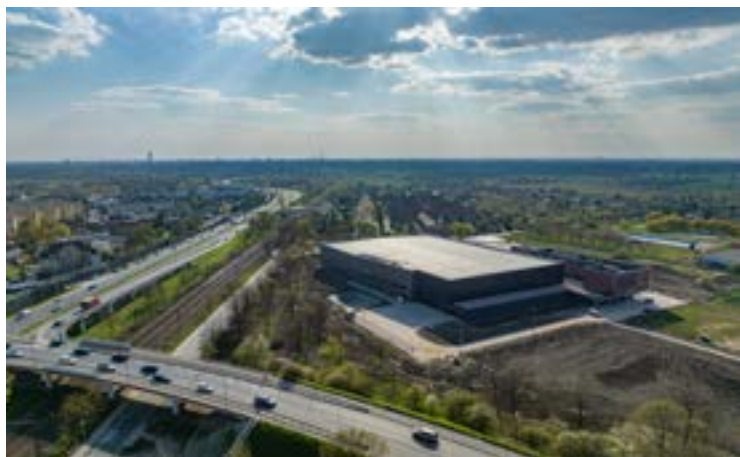
Fot. Hala na wrocławskich Kłokoczycach
