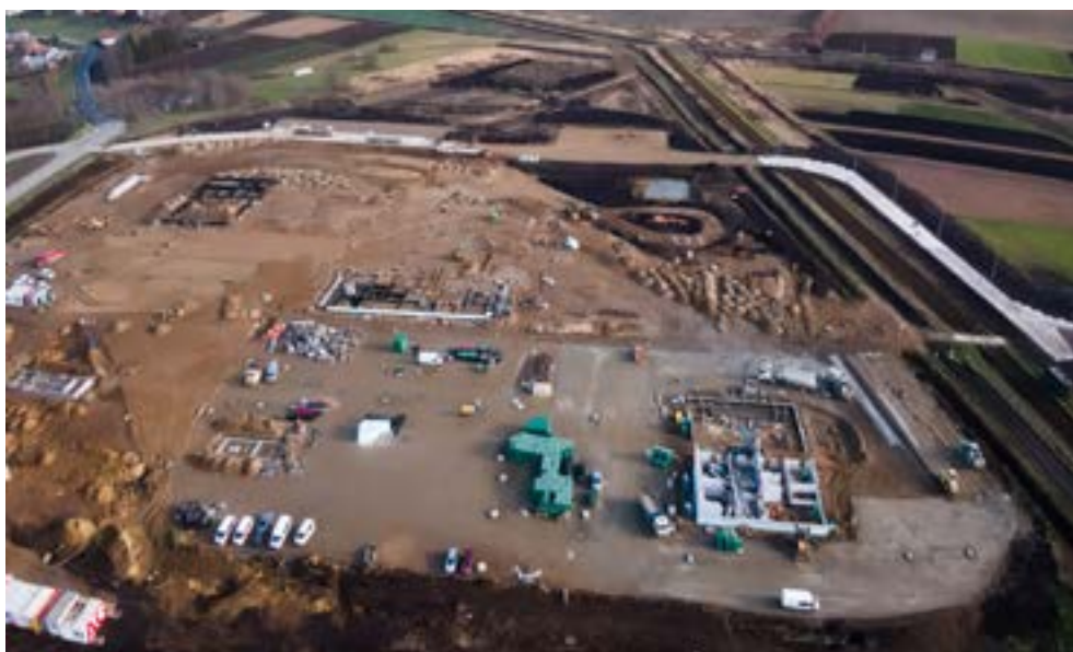
Fot. Plac budowy z lotu ptaka w styczniu 2023 r.
